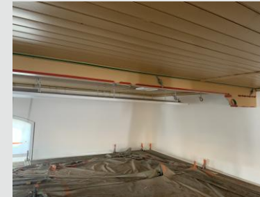
Turnhalle - Farbgebung Decke nach restauratorischem Befund
