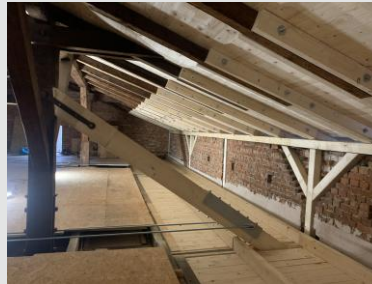
Turnhalle - Dachstuhl nach Sanierung
